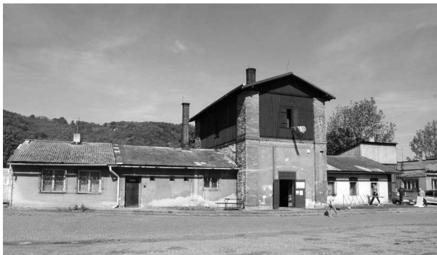
Střekovská parní vodárna (foto Zubnická museální železnice)
