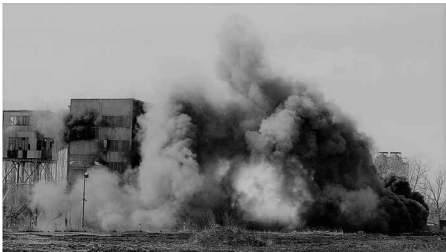
Demolice části třídírny v Úžíně odstřelem 21. 3. 1998, kde explodoval uhelný prach (foto K. Walter)
