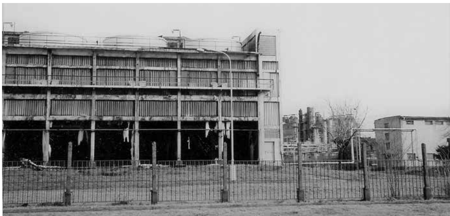
Chladicí věže (foto K. Walter)
