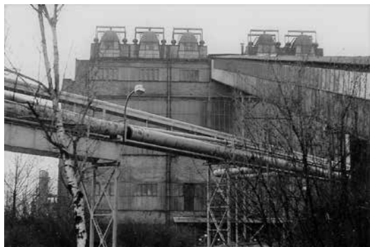
Objekt sušárny uhlí s elektrostatickými odlučovači multiprachy (foto K. Walter)
