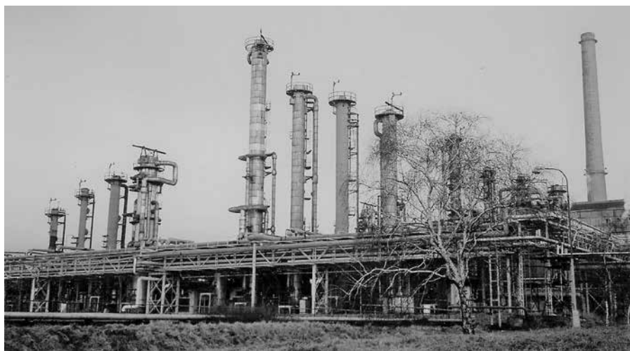
Maximální výkon dvou čisticích řad provozu Rectisol byl v každé řadě 53 000 m 3 surového plynu za hodinu (foto K. Walter)
