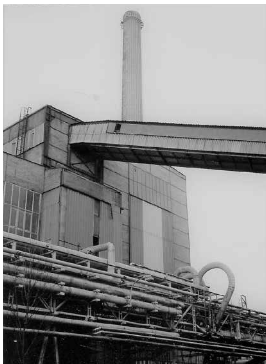
Fotografie provozu teplárny (foto K. Walter)
