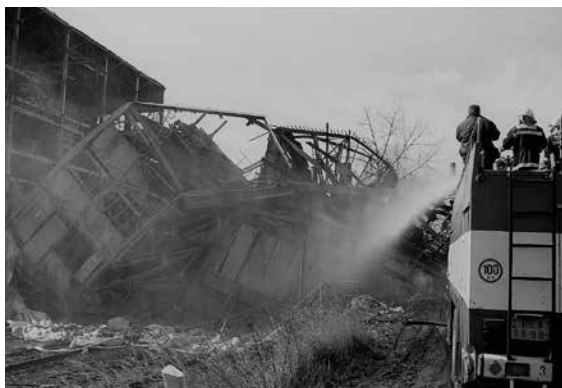
Zásah hasičů při demolici třídírny (foto K. Walter)
